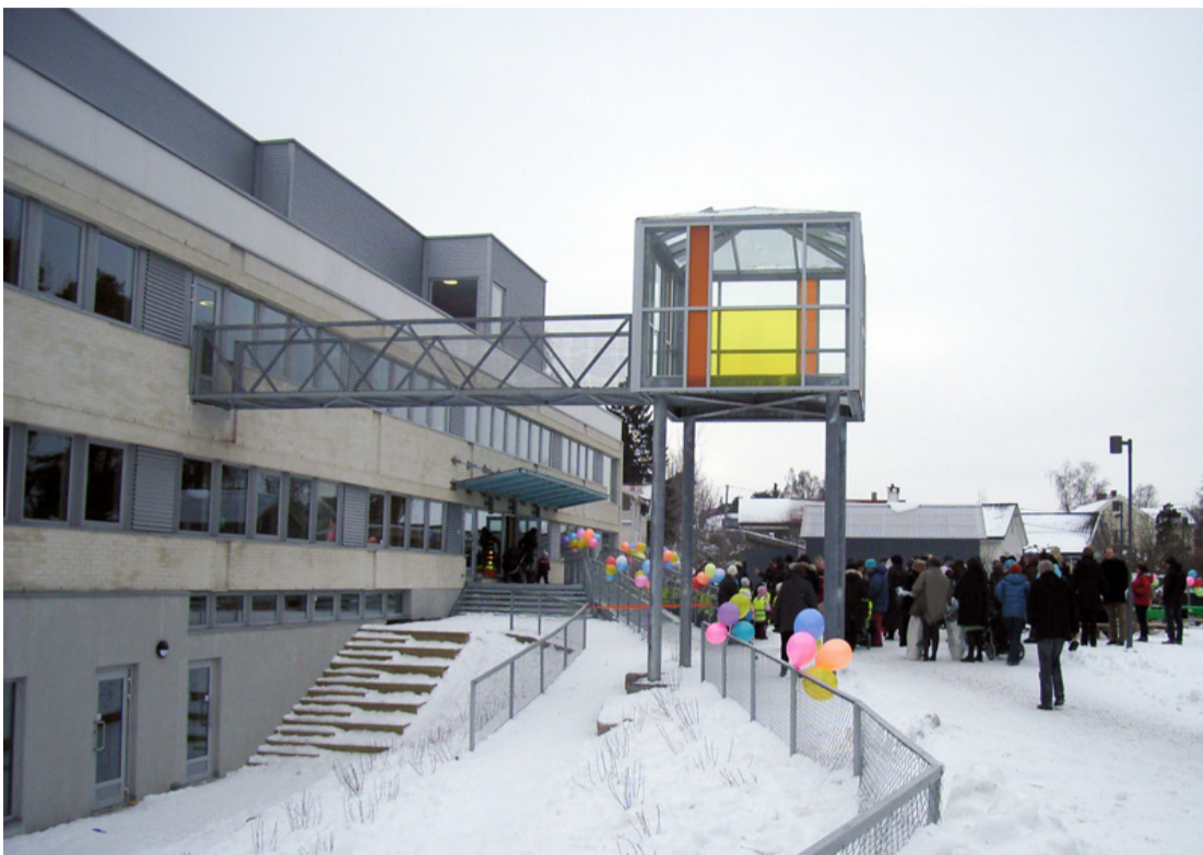
Fra den offisielle åpningen etter at Rosenhagen barnehage hadde flyttet inn i bygget som ble kalt Forsvarsbygget i Rosendalsveien i desember 2008. Her trives i dag 135 barn i alder 1 – 6 år, som har mange muligheter for innendørs aktiviteter og stort uteareal.
